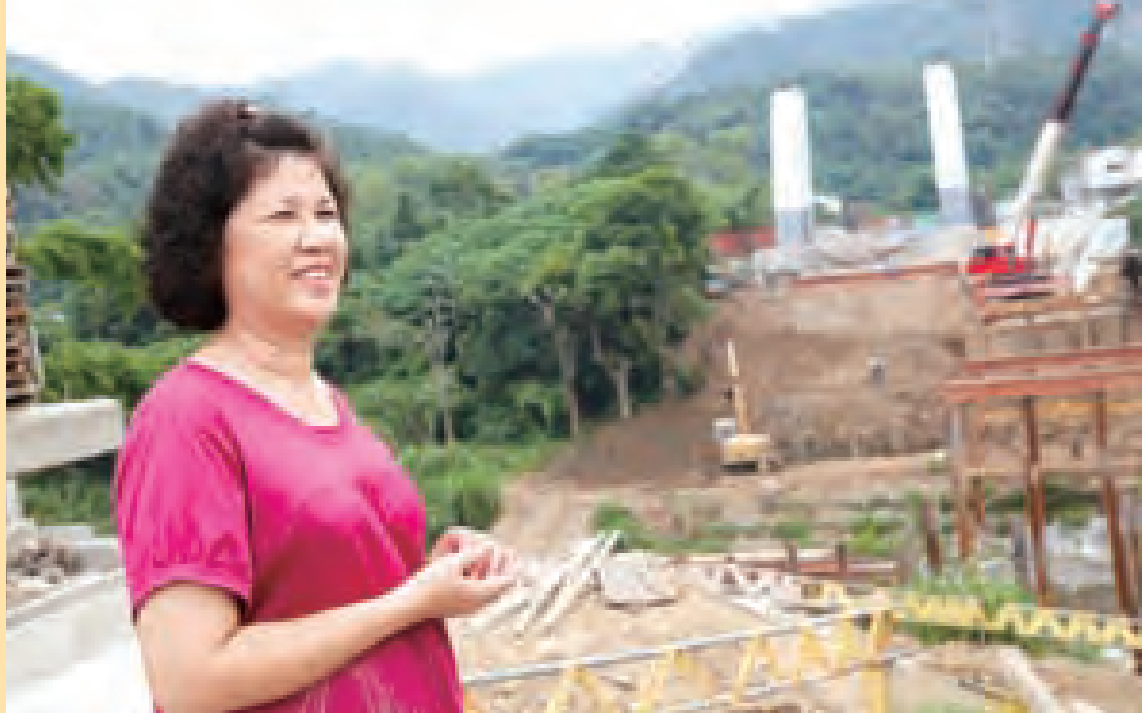
高鄔梅英看著進行中的平埔橋工程建設，心中期許能為深坑區開創更多新商機。
