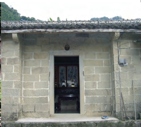
■ 三峽鎮山客的砂岩打製的石頭屋
